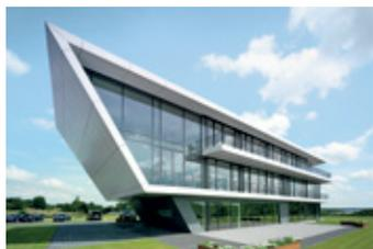
Facciata Schüco FWS 50 / FWS 60 – lo sviluppo naturale della collaudata facciata a montanti e traversi Schüco FW 50+ / FW 60+ . In termini di libertà di progettazione e isolamento termico, offre un'ampia gamma di opzioni per l'implementazione di facciate verticali e coperture.
