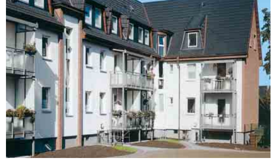
Nachher: Wertsteigerung durch Balkone ... after: increase in value with balconies
