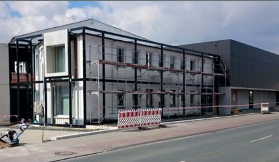
Bestandsfassade mit Unterkonstruktion Existing façade with substructure
